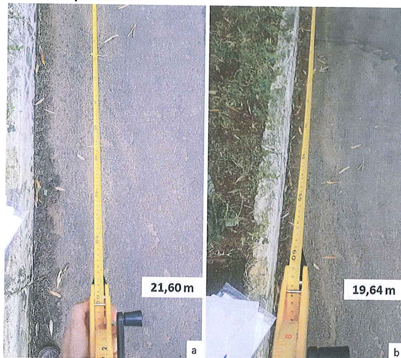
Figura 3 - Registro fotográfico das distâncias medidas entre a lateral do terreno e as possíveis localizações da rede de distribuição da av. Coronel Theodomiro P. da Fonseca: a) rede sob o leito da via; b) rede sob o passeio.
