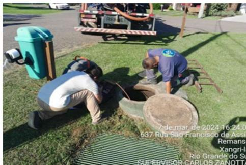
Figura 5 - Câmera sendo inserida em poço de visitação.
