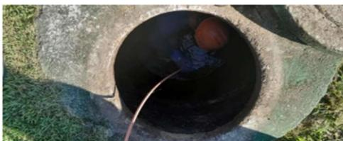
Figura 6 - Operador inserindo a câmera na tubulação, dentro do poço de visitação.
