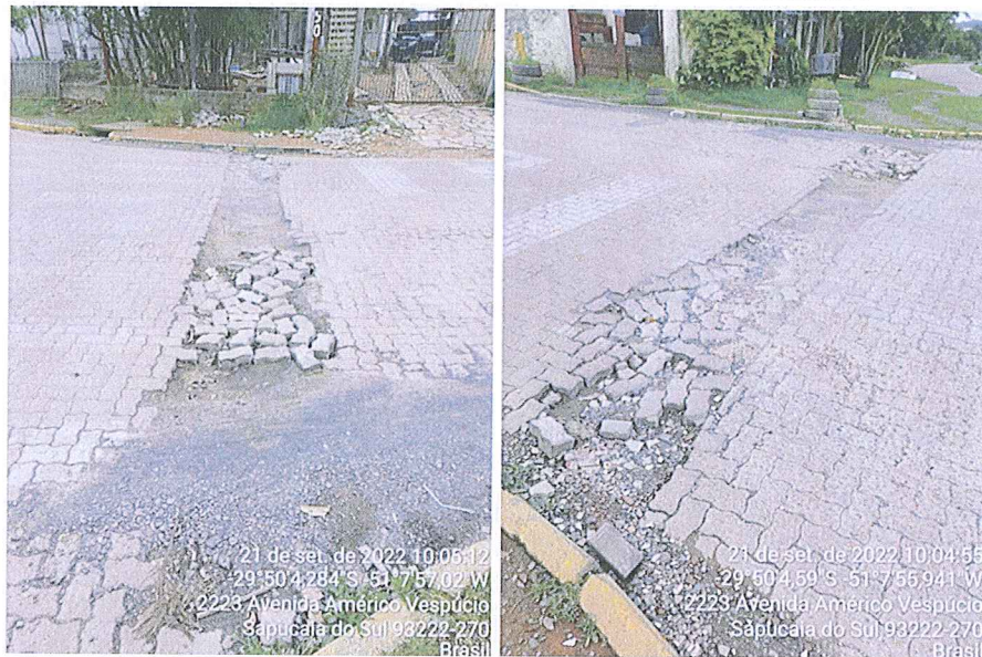
Figura 2 - Registros fotográficos do local fiscalizado.
