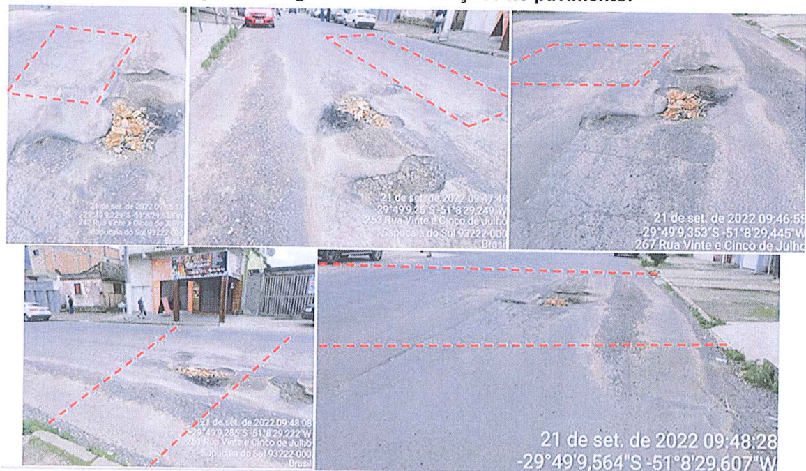
Figura 4 - Registro das intervenções no pavimento.
