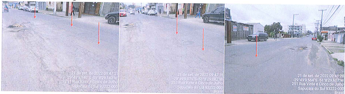
Figura 3 - Registro fotográfico de pontos onde possivelmente foram realizadas obras na rede de abastecimento de água da Corsan.
