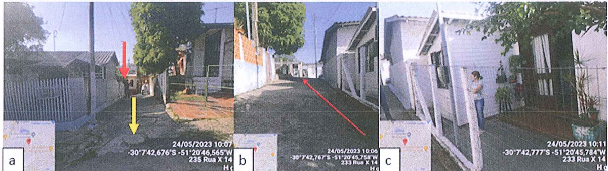
Figura 2 – Registro fotográfico da evidência de caixa de ligação: a) Vista geral do início da rua onde fica localizada a caixa de ligação e residência; b) Vista do caimento da rua até a residência; c) Vista da parte frontal do imóvel;
