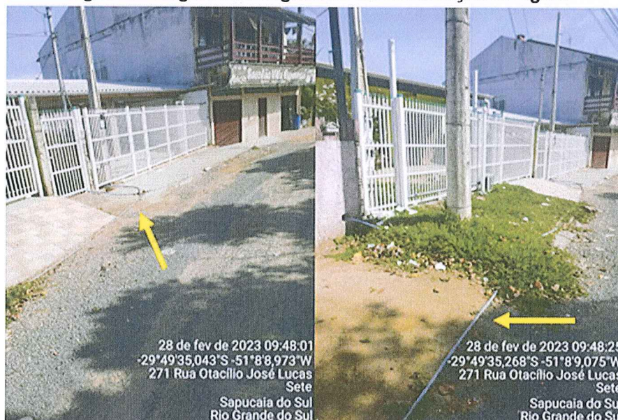
Figura 3 - Registros fotográficos da canalização de água.
