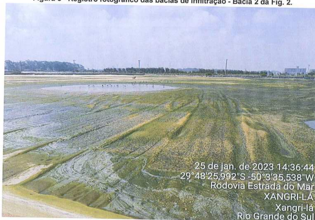
Figura 5 - Registro fotográfico das bacias de infiltração - Bacia 2 da Fig. 2.
