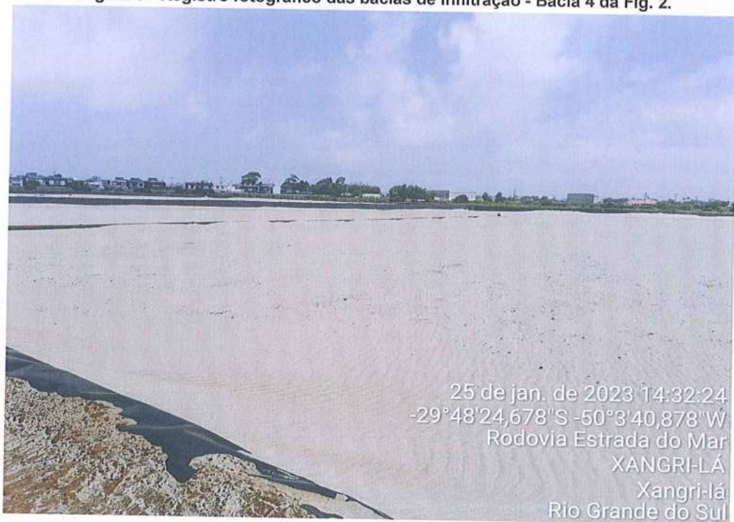
Figura 6 - Registro fotográfico das bacias de infiltração - Bacia 4 da Fig. 2.
