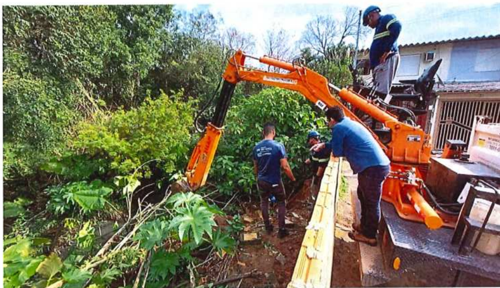
Imagem 3: Limpeza para identificação da rede.
