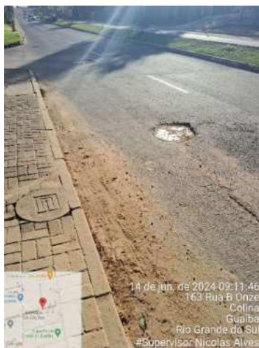
Imagem 01, Vistoria realizada no dia 14/06/2024 na Rua Lorival Luís da Cunha Ponto 1.
