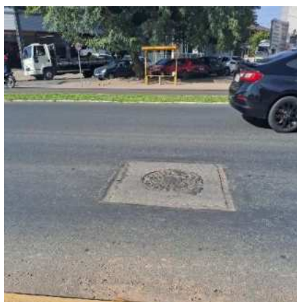
Imagem 11. Vistoria realizada no dia 14/06/2024 na Rua Nestor Moura Jardim.
