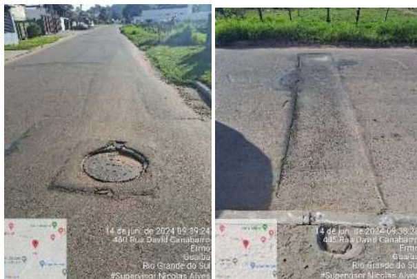
Imagem 05 e 06, Vistoria realizada no dia 14/06/2024 na Rua David Canabarro.
