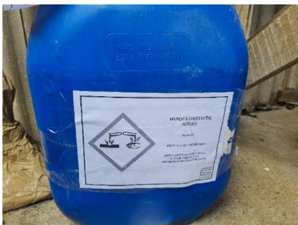
Imagem 03: NC 13 - Foto da Bombona utilizada para armazenamento de hipoclorito devidamente identificada.
