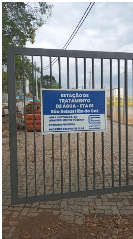
Imagem 02: NC 10 - Foto da Placa de identificação ETA.
