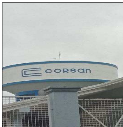
Figura - Reservatório com SPDA instalado
