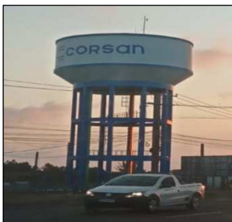
Figura - Reservatório com SPDA instalado.
