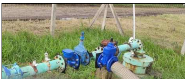
Figura - Equipamentos reparados sem vazamento
