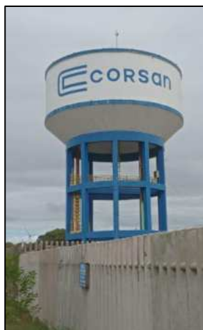
Figura - Reservatório com SPDA instalado
