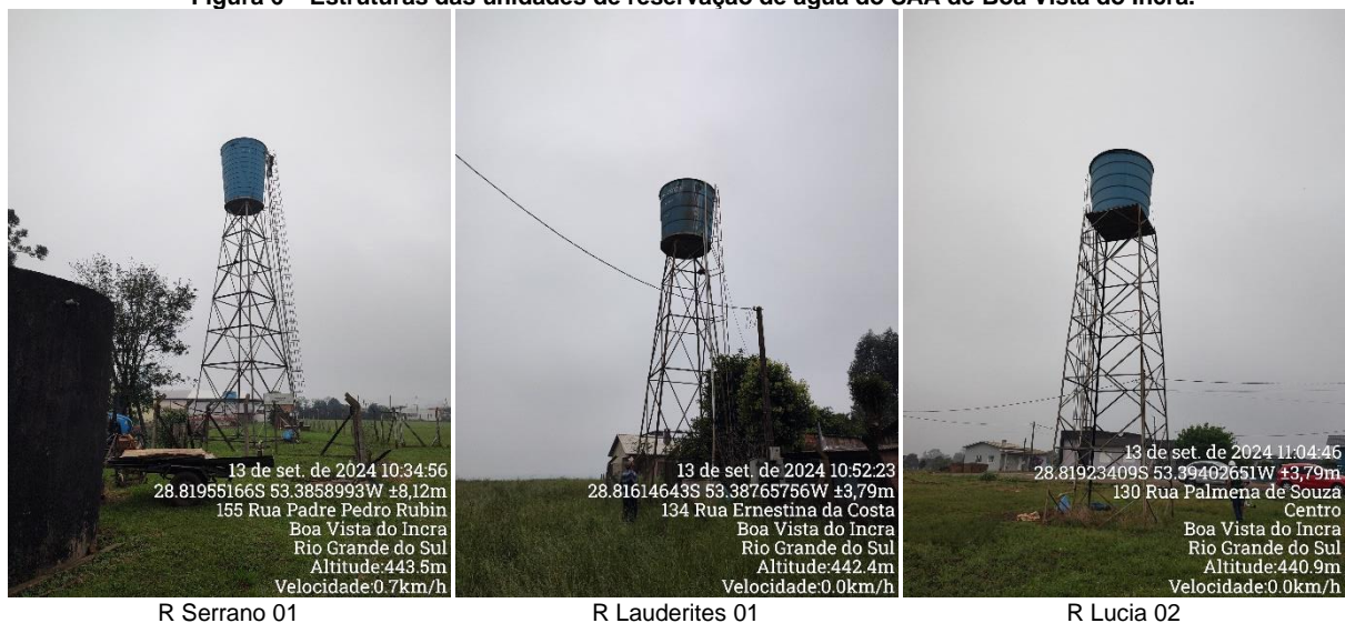
Figura 6 – Estruturas das unidades de reservação de água do SAA de Boa Vista do Ingra.
