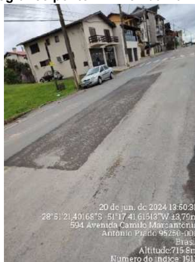
Figura 2- Registro fotográfico ponto 1 - Avenida Camilo Marcantônio
