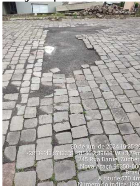
Figura 8- Registro fotográfico ponto 7 - Rua Silvestro Pedro Cerri, 235
