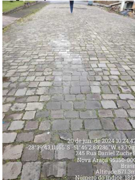
Figura 7- Registro fotográfico ponto 6 - Rua Silvestro Pedro Cerri, 200-230
