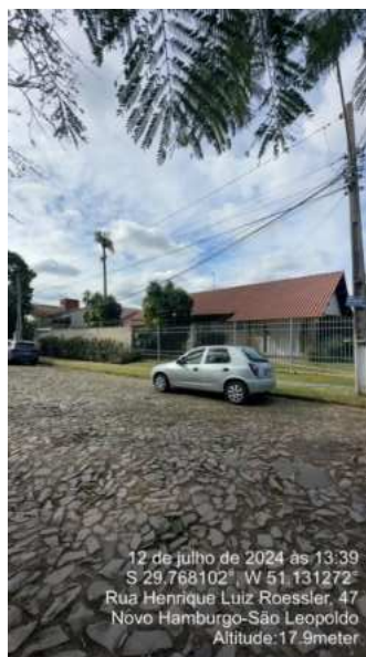
Figura 2 – visão geral da calçada onde está localizada a caixa de esgoto e o da residência.
