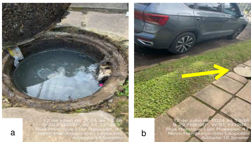
Figura 3– Registros fotográficos com: (a) o interior da caixa de esgoto e (b) a visão geral da calçada.
