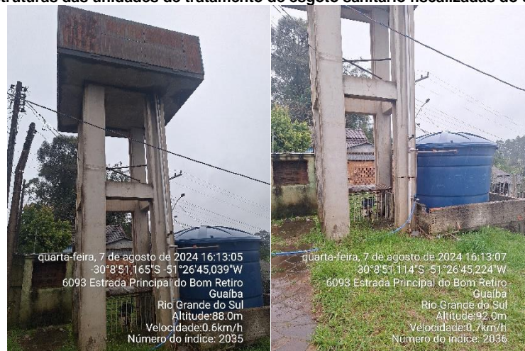
Figura 6 – Estruturas das unidades de tratamento de esgoto sanitário fiscalizadas do SES de Guaíba.
