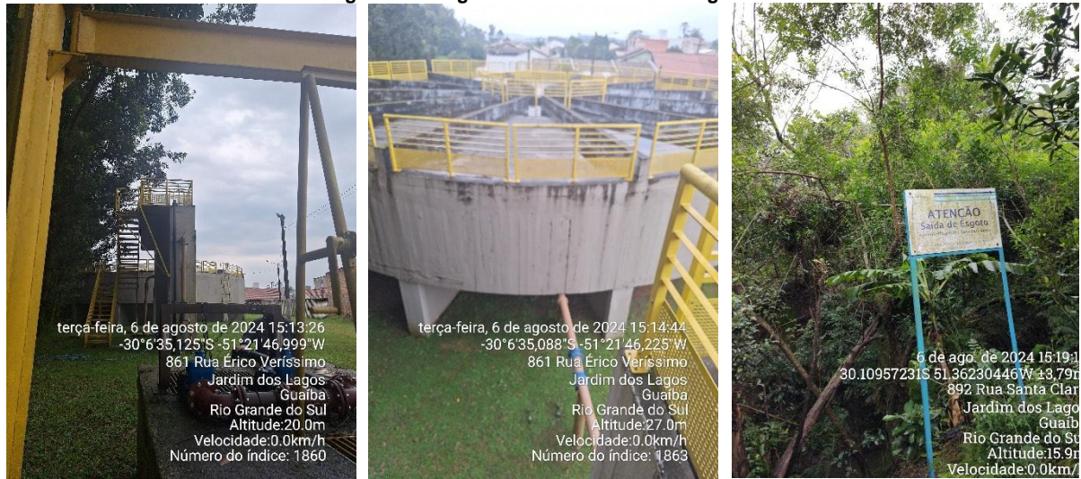
Figura 9 – Imagens da ETE Jardim dos Lagos.
