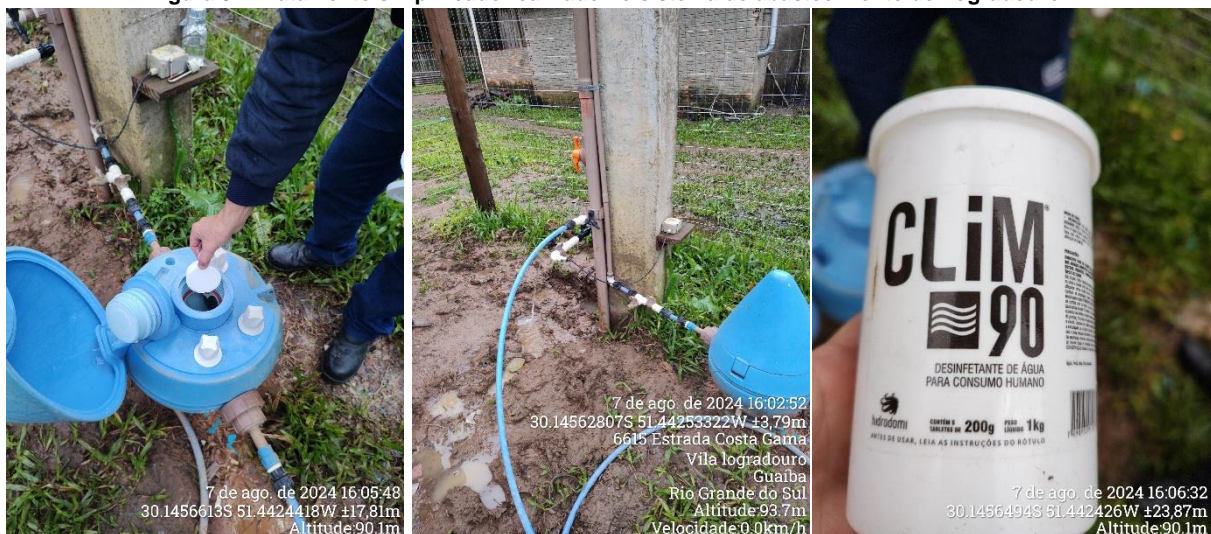
Figura 5 – Tratamento simplificado realizado no sistema de abastecimento de Logradouro.
