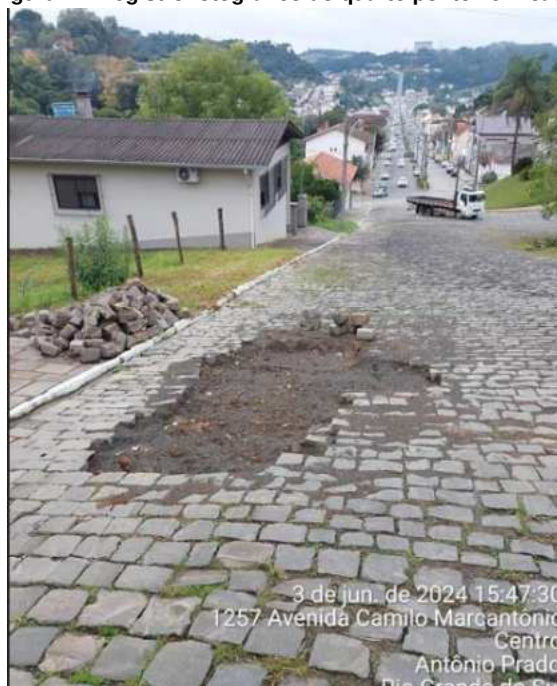
Figura 4 – Registro fotográfico do quarto ponto verificado.
