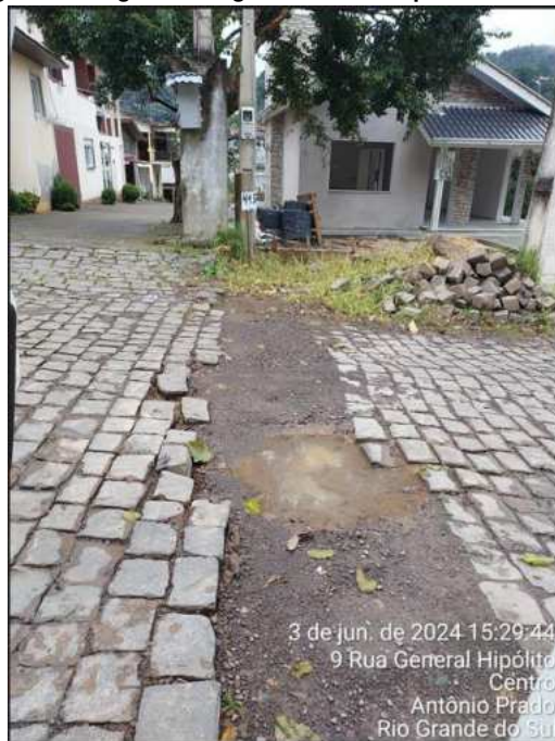
Figura 9 – Registro fotográfico do nono ponto verificado.
