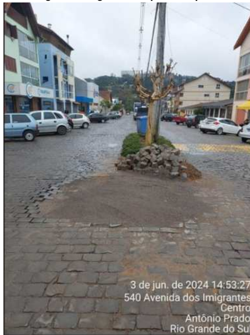
Figura 1 – Registro fotográfico do primeiro ponto verificado.
