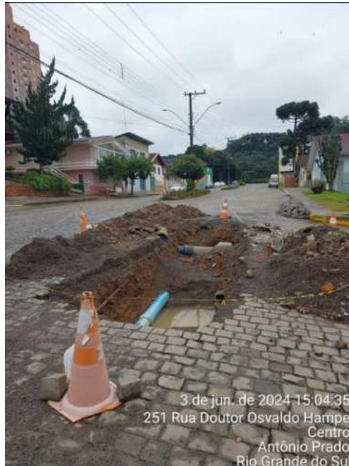
Figura 6 – Registro fotográfico do sexto ponto verificado.
