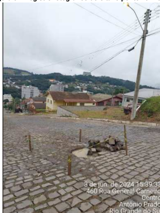
Figura 8 – Registro fotográfico do oitavo ponto verificado.
