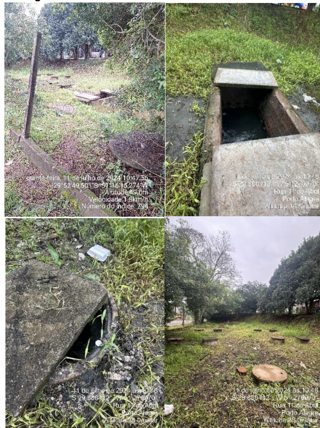
Figura 02 – Sistema coletivo de fossa e filtro anaeróbio.
