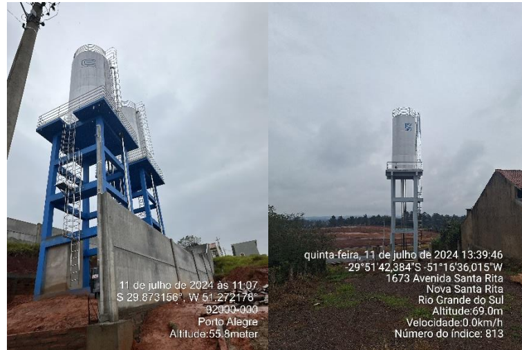
Figura 01 – Reservatórios em fase de instalação.
