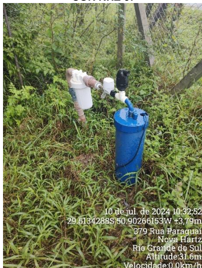
Figura 3 – Cloração em unidade de contato no poço COR NHZ 07
