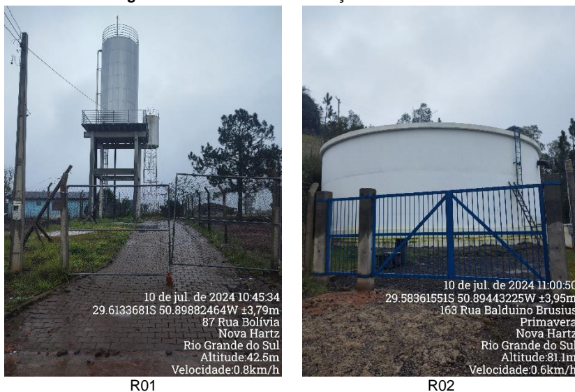
Figura 6 - Estruturas de reservação de Nova Hartz.
