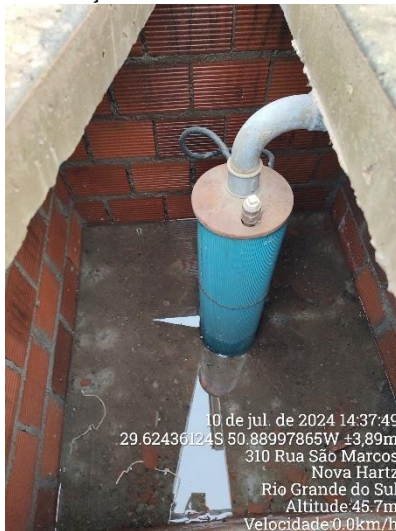
Poço Loteamento Bela Vista
