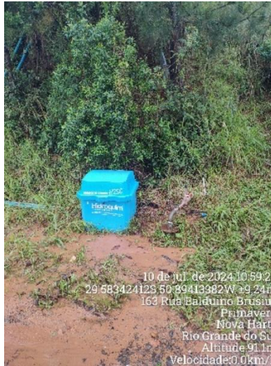
Poço Loteamento Brusius
