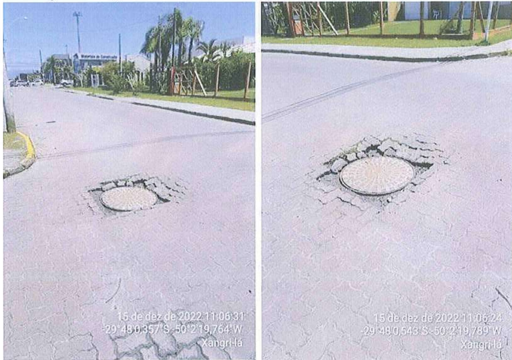
Figura 8 - Registro fotográfico do Ponto 7 na esquina da Rua Rio Tainhas e Rua Rio Ibirapuitã.
