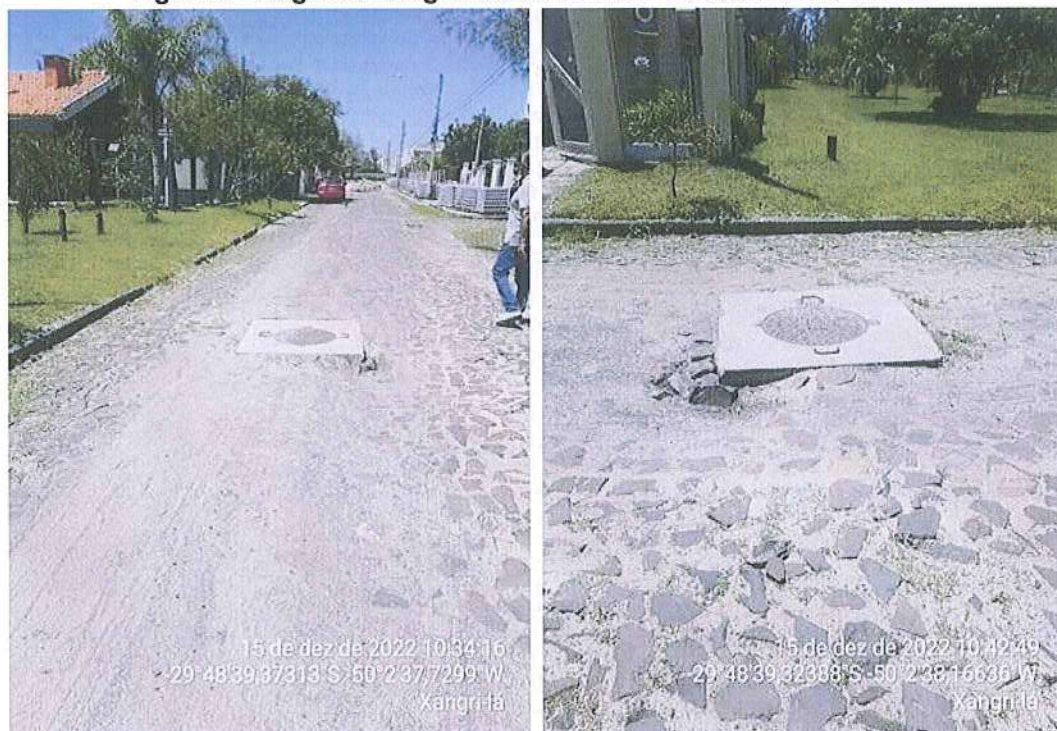
Figura 3 - Registro fotográfico do Ponto 2 na Rua Rio da Várzea.
