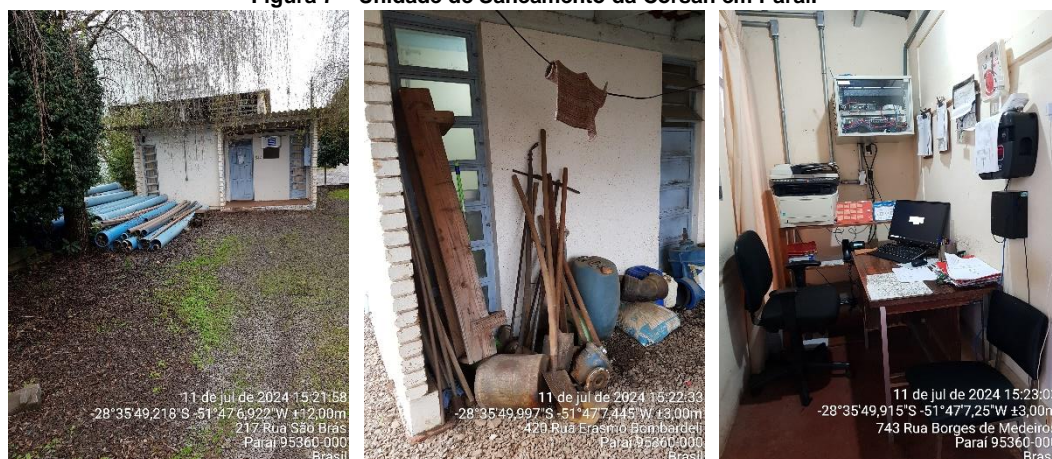
Figura 7 – Unidade de Saneamento da Corsan em Paraí.
