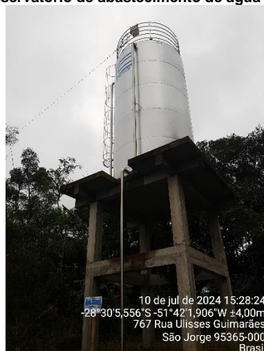
Figura 4 – Reservatório de abastecimento de água em São Jorge.
