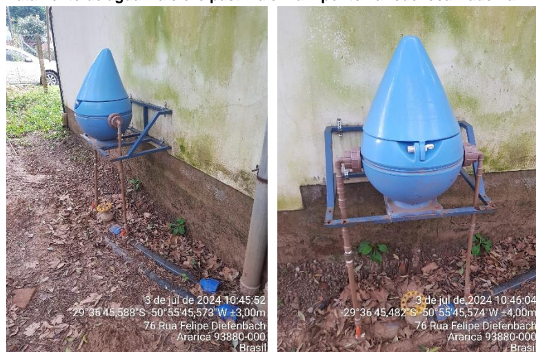
Figura 1 – Tratamento de água via cloro pastilha em um ponto na rede localizado na EBAT Campo.
