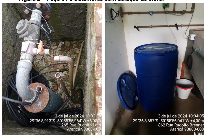
Figura 2 – Poço 01 e tratamento com solução de cloro.
