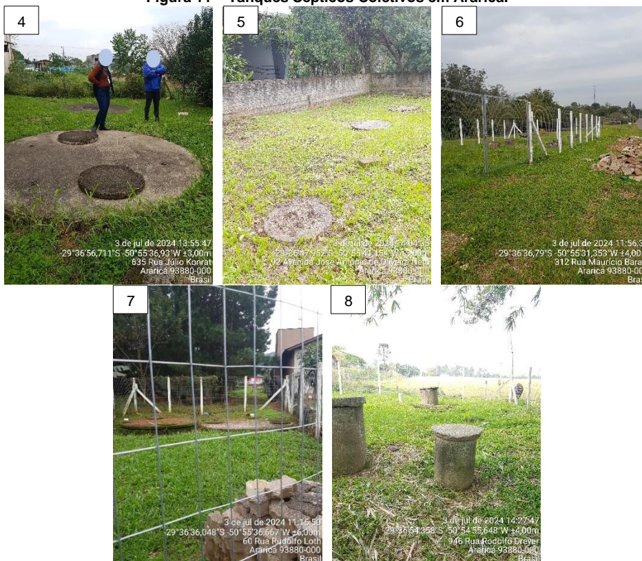
Figura 11 – Tanques Sépticos Coletivos em Araricá.
