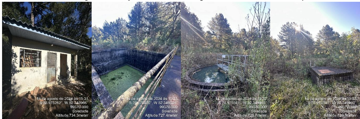
Figura 10 – Estação de tratamento de esgoto sanitário existente no município
