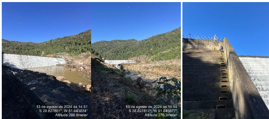
Captação (montante da barragem)
