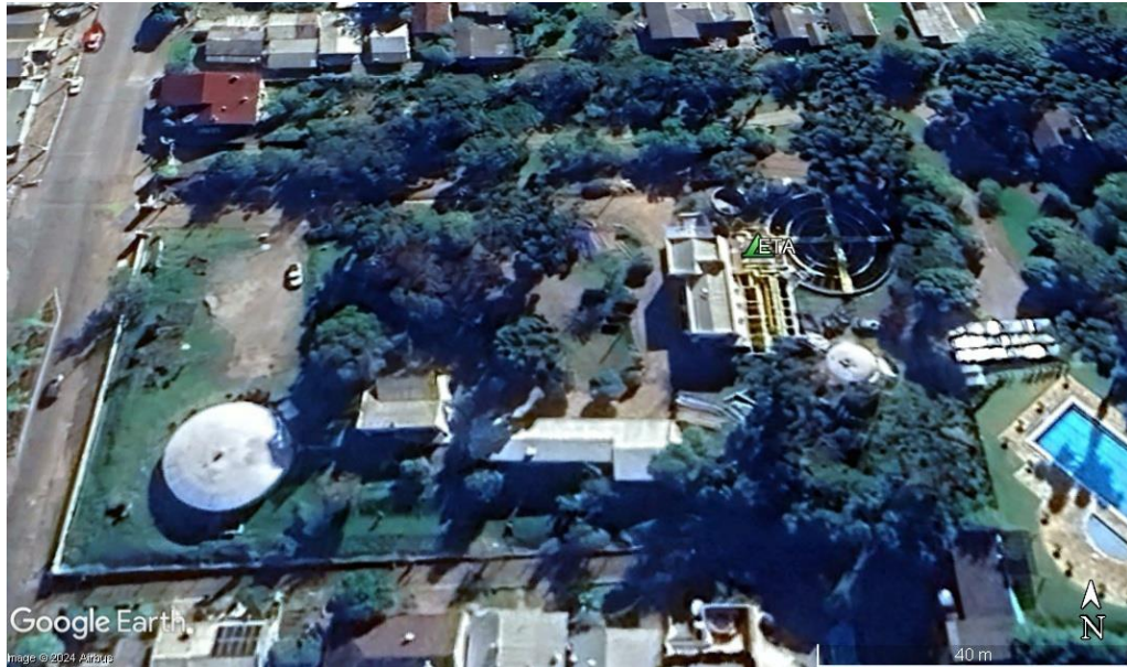
Figura 4 – Imagem de satélite da ETA de Guaporé.
