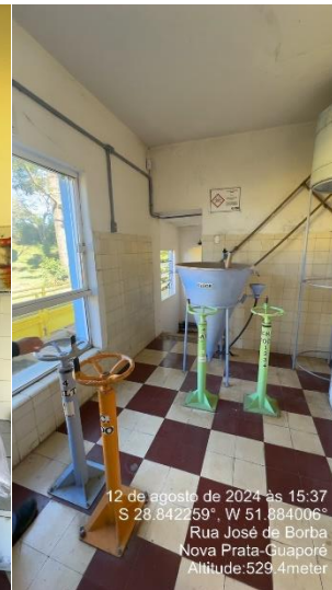
Armazenamento do fluossilicato de sódio e ponto de dosagem
