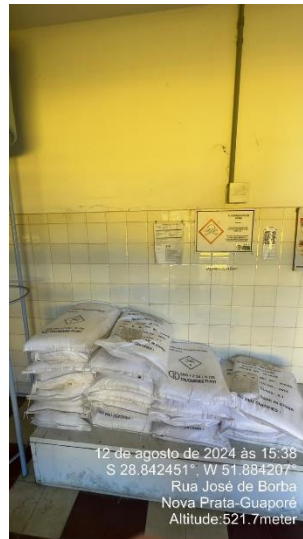
Armazenamento do fluossilicato de sódio e ponto de dosagem
