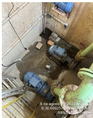
Bombas da EBAT
