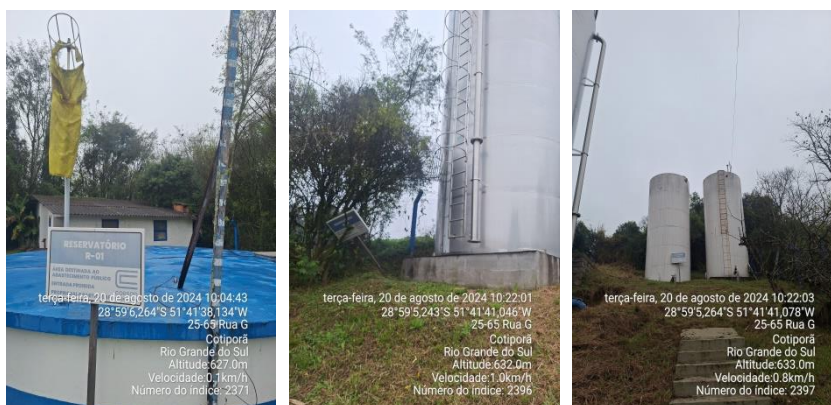
Figura 9 – Reservatórios de abastecimento de água em Cotiporã.
