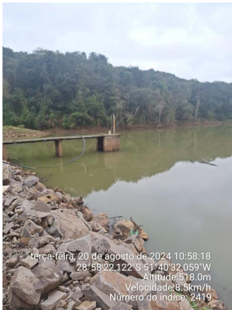
Figura 1 – Captação Arroio Leão do sistema de abastecimento de água de Cotiporã.
