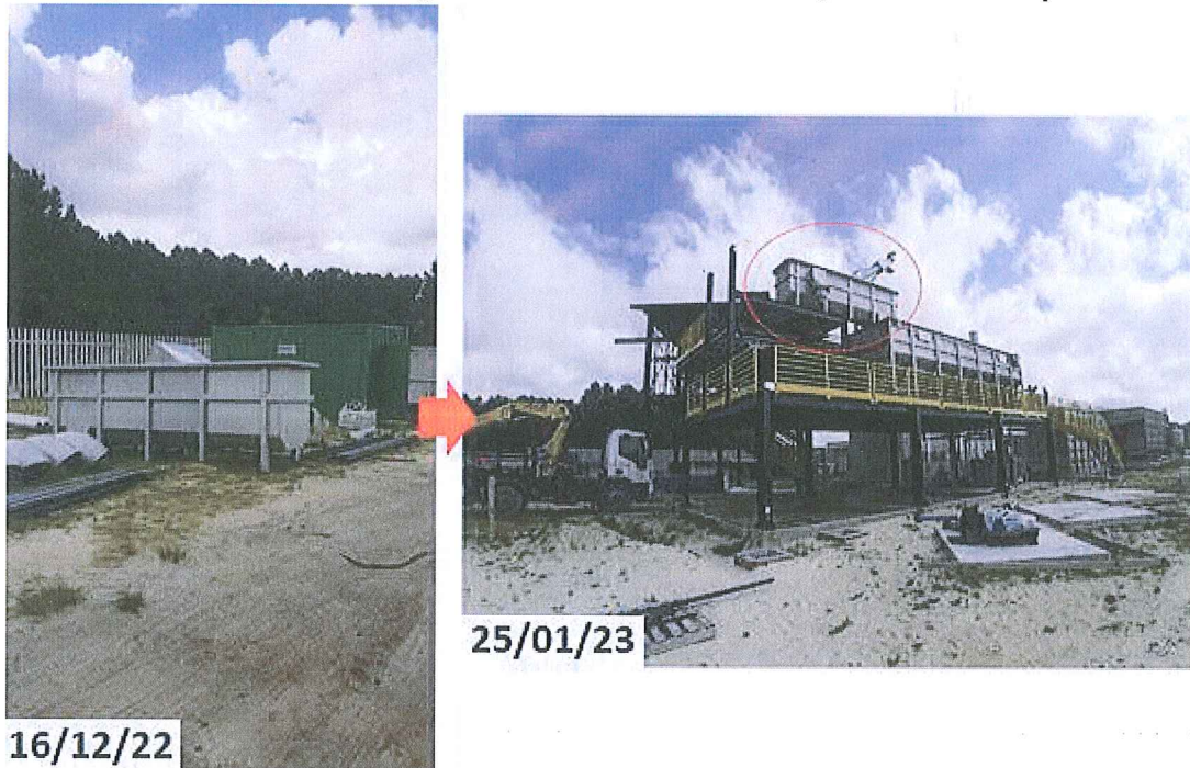
Figura 8 - Registros fotográficos das obras de instalação da ETE compacta.
