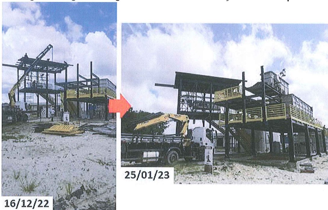
Figura 9 - Registros fotográficos das obras de instalação da ETE compacta.
