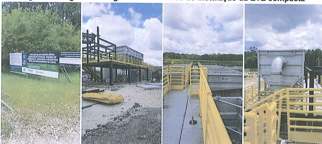
Figura 7 - Registros fotográficos das obras de instalação da ETE compacta
