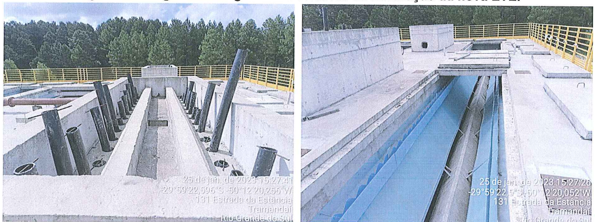
Figura 11 - Registros fotográficos das obras de instalação da nova ETE.
