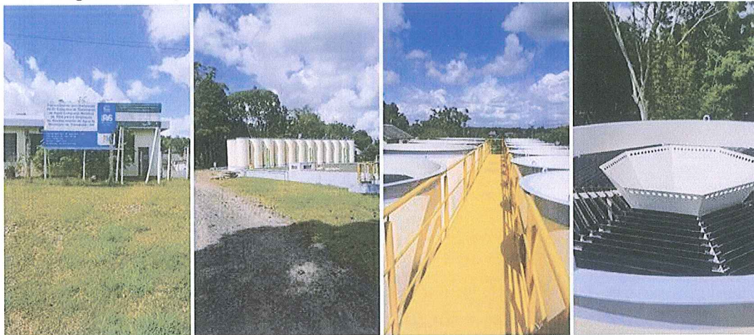
Figura 2 - Registro fotográfico das obras de instalação da ETA Compacta
