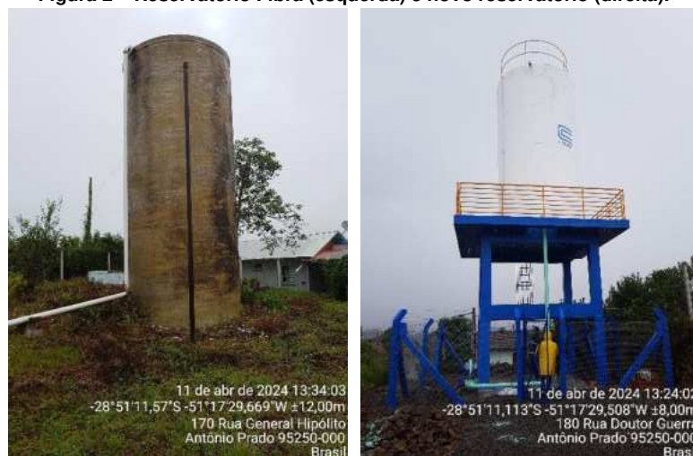
Figura 2 – Reservatório Fibra (esquerda) e novo reservatório (direita).
