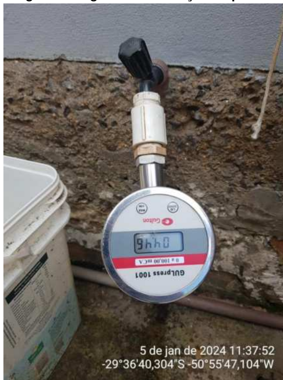
Figura 2 - Registro fotográfico da medição de pressão realizada.
