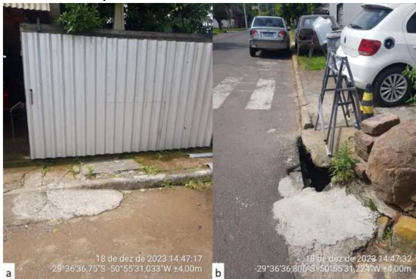
Figura 2 – Registro fotográfico da residência: a) Vista da caixa de inspeção da rede pluvial; b) Vista da boca de lobo da rede pluvial.
