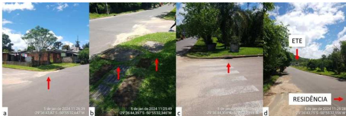
Figura 2 – Registro fotográfico da residência: a) Vista da residência; b) Vista da caixa de passagem da rede de drenagem; c) Vista da boca de lobo da rede de drenagem; d) Vista da Av. Dr. Maurício Barani no trecho entre a ETE e a residência.
