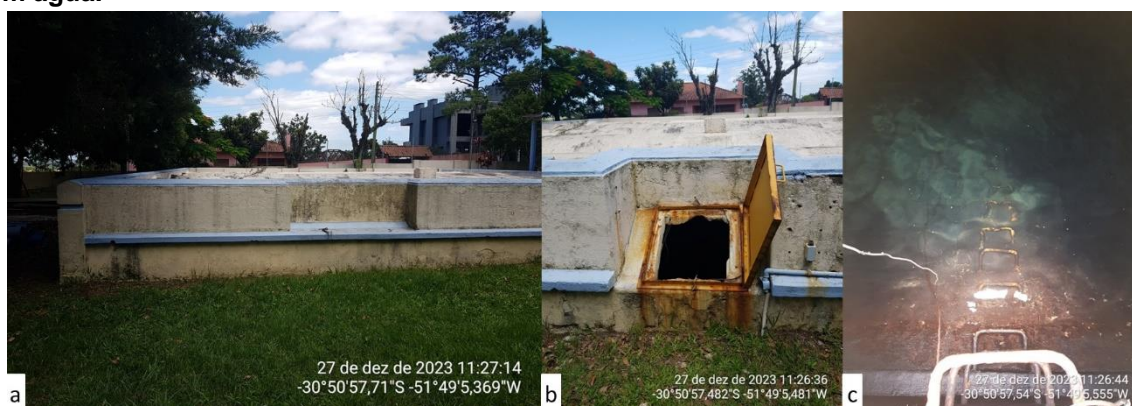
Figura 1 – Registro fotográfico do reservatório semienterrado localizado junto US: a) Vista geral do reservatório; b) Vista da tampa de acesso do reservatório; c) Vista interna reservatório com água.
