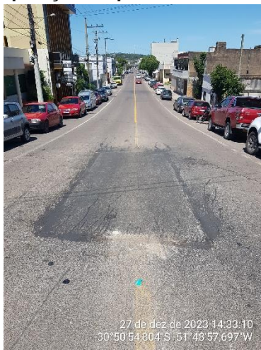
Figura 8 - Vista da obra de recomposição do pavimento na Rua Cristóvão Gomes de Andrade.
