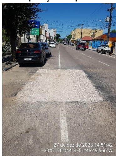
Figura 9 - Vista da obra de recomposição do pavimento na Rua Marechal Floriano.
