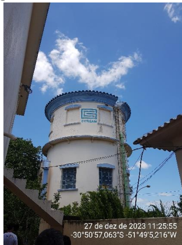
Figura 3 - Registro fotográfico do reservatório elevado localizado junto à US.
