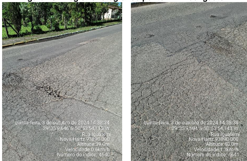
Figura 15 - Registro fotográfico ponto 14 - Rua Iguatemi
