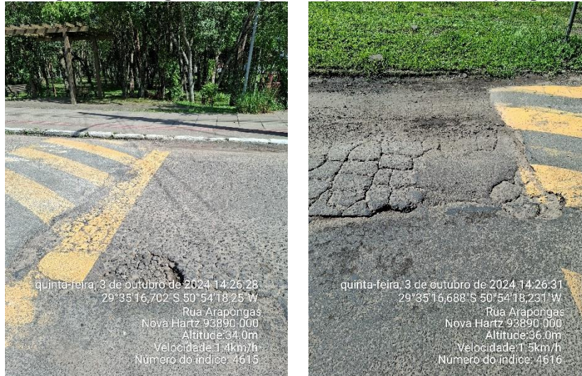
Figura 13 - Registro fotográfico ponto 12 - Rua Arapongas
