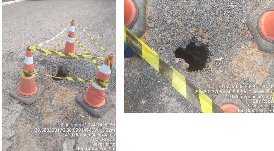
Figura 11 - Registro fotográfico ponto 10 - Rua Venâncio Aires
