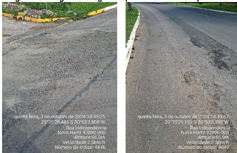
Figura 16 - Registro fotográfico ponto 15 - Rua Independência
