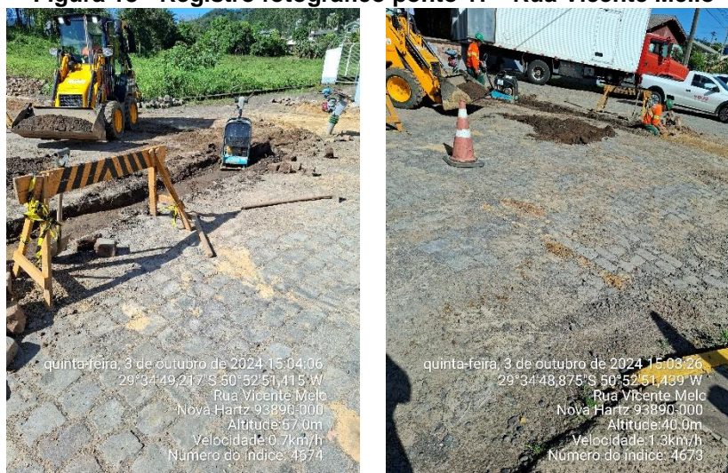
Figura 18 - Registro fotográfico ponto 17 - Rua Vicente Mello
