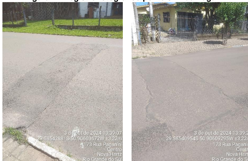
Figura 4 - Registro fotográfico ponto 3 - Rua Paganini
