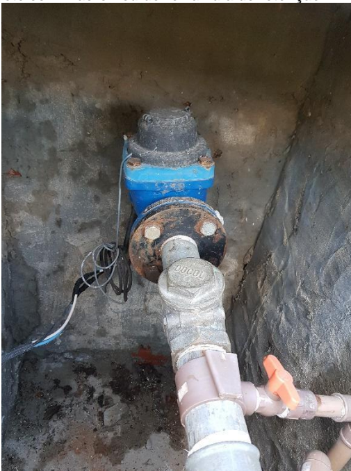
Figura 2g – Caixa de proteção do poço P-1 (vista interna), barrilete com macromedidor e válvula de retenção.
