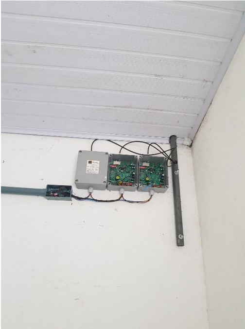
Figura 12g – Quadro de Comando (Vista interna. Fora da Norma).
