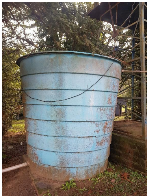
Figura 9c – Reservatório Apoiado de Fibra.
