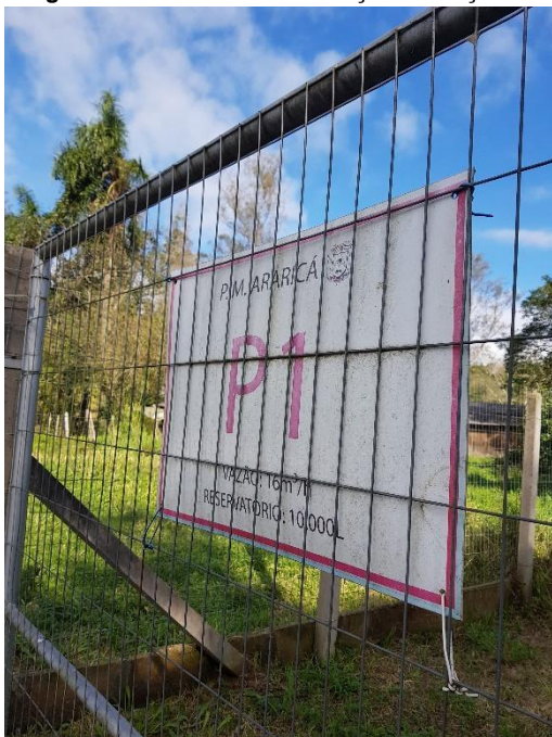
Figura 2a – Placa de identificação do Poço P-1
