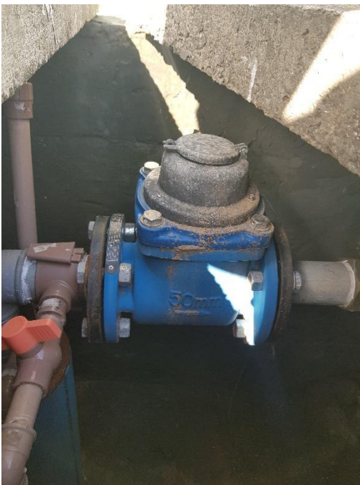
Figura 3e – Caixa de proteção do poço (vista interna) com macromedidor e barrilete em FºFº.
