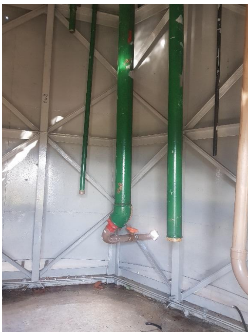
Figura 10c – Reservatório Elevado (parte interna).
