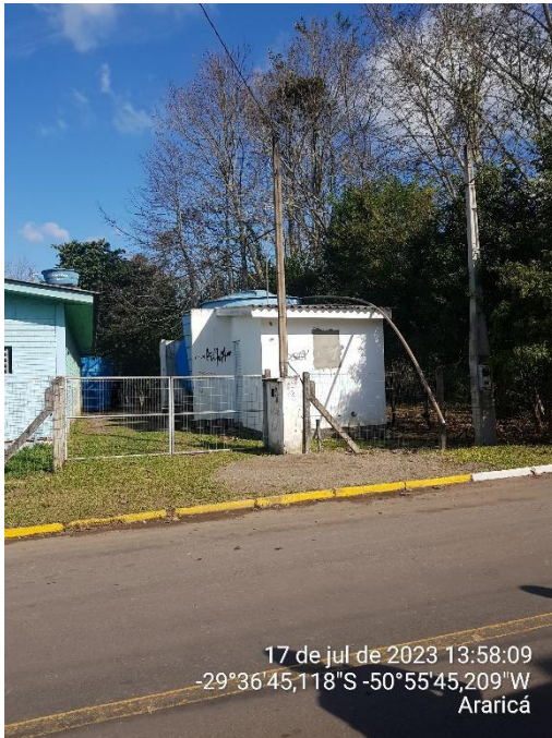
Figura 12a – Vista da Elevatória do Campo, Portão de Acesso, com Saída do Recalque.
