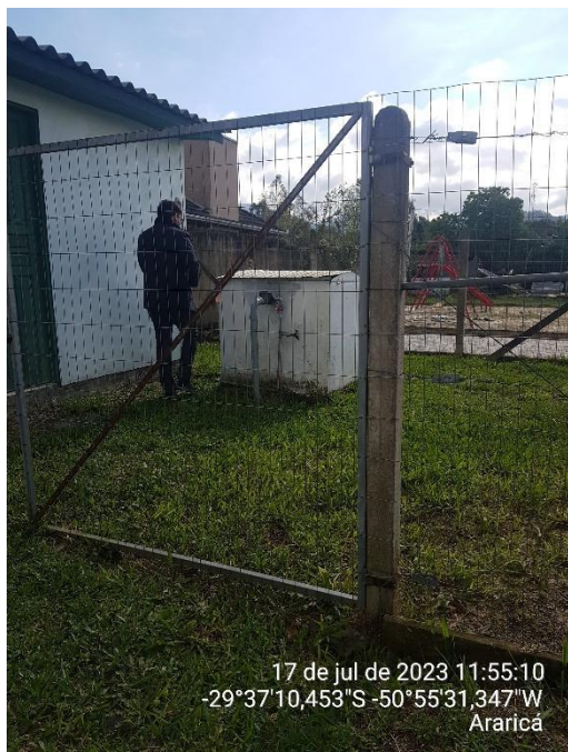
Figura 4a – Vista Frontal do terreno do Poço P-7
