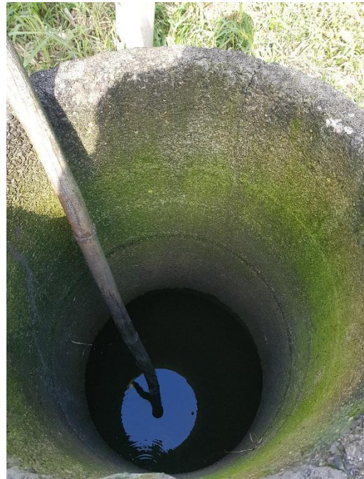
Figura 18b – Vista de Acesso à Unidade de Tratamento.
