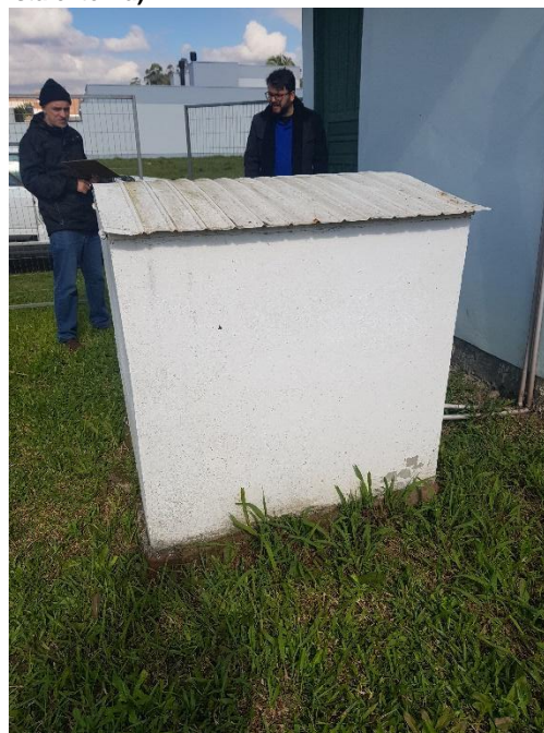
Figura 4b – Vista da Caixa de Proteção do Poço P-7 (vista externa)
