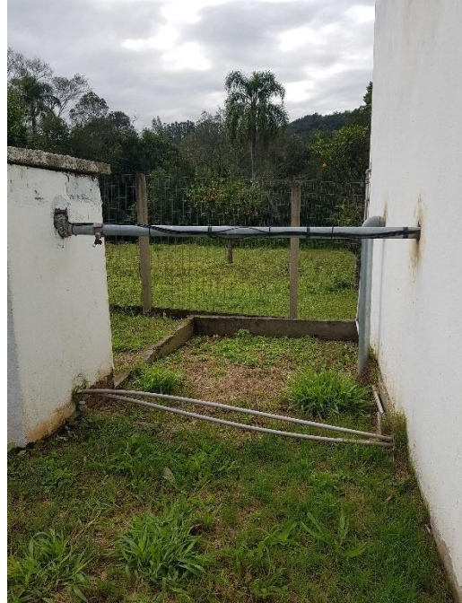
Figura 1h – Barrilete em FºFº, entre a caixa de proteção e o R4 e tubulação de saída em FºFº.
