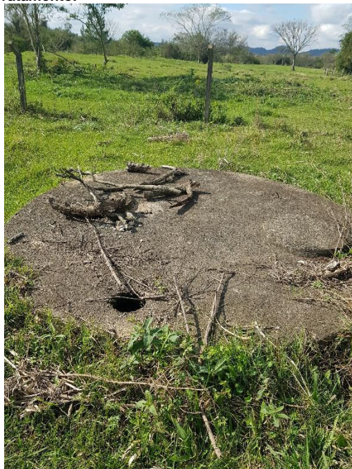
Figura 15d – Vista de Uma das Unidades de Tratamento.
