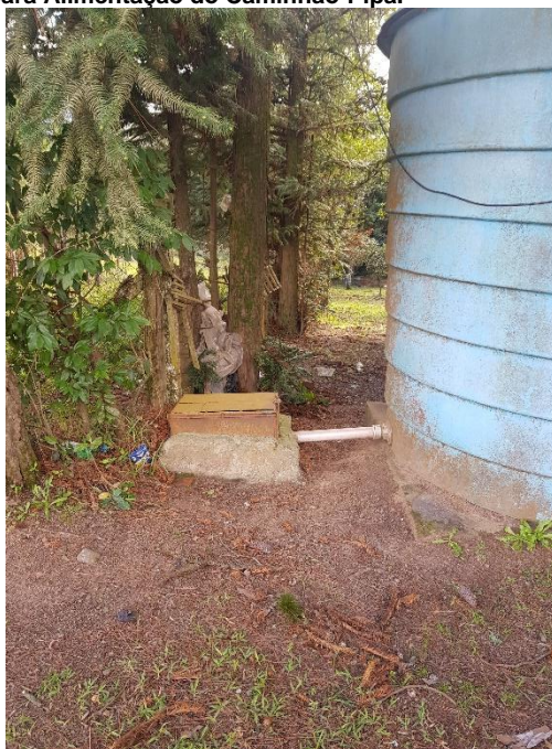
Figura 9d – Caixa Metálica do Registro de Manobra para Alimentação do Caminhão-Pipa.
