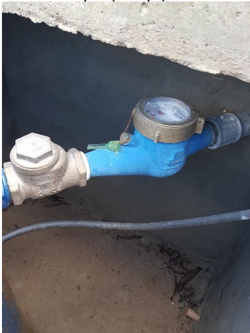
Figura 5c – Caixa de proteção do poço com macromedidor.
