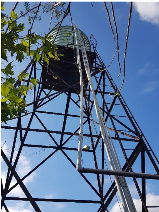
Figura 11e – Reservatório Elevado.
