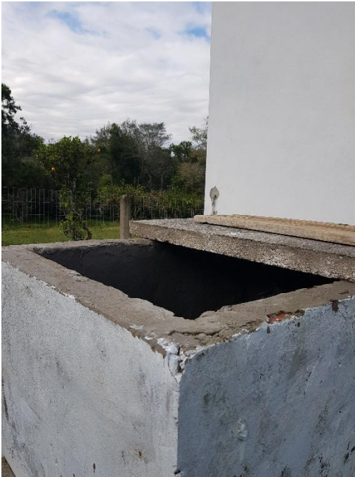
Figura 1e – Caixa de Proteção do Poço.
