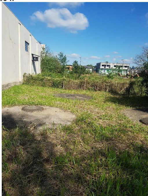
Figura 13c – Vista das Unidades de Tratamento da ETE Centro 1.
