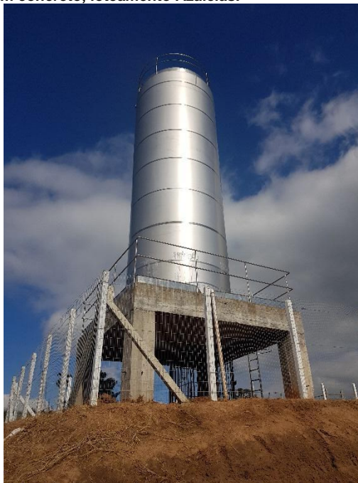
Figura 8d – Reservatório metálico com base elevada em concreto, loteamento Azaleias.
