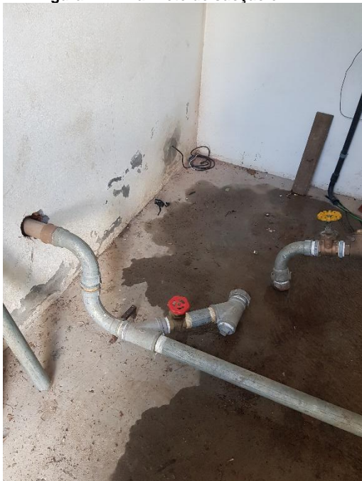
Figura 12i – Barrilete de sucção em F 0 F 0 .
