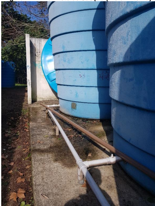
Figura 12k – Barrilete de Sucção (Vista Externa).
