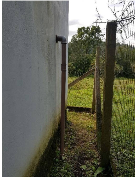
Figura 1n – Derivação em PVC (vista externa).
