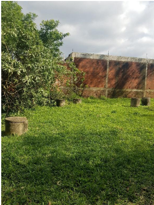
Figura 14c – Vista Lateral das Unidades de Tratamento da ETE Centro 2.
