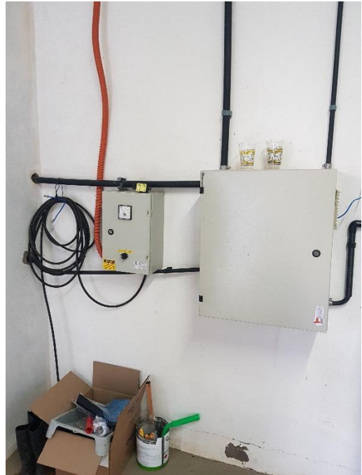
Figura 5h – Quadros de Comando (vista externa).
