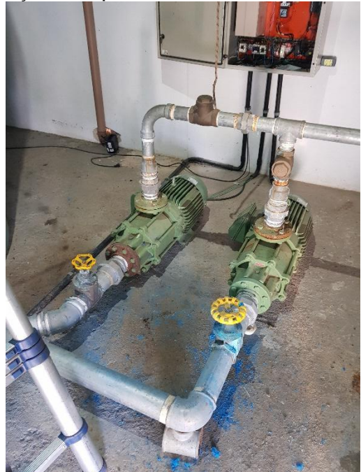
Figura 2l – Conjuntos motobomba 1 e 2, barriletes de sucção e recalque em FºFº.
