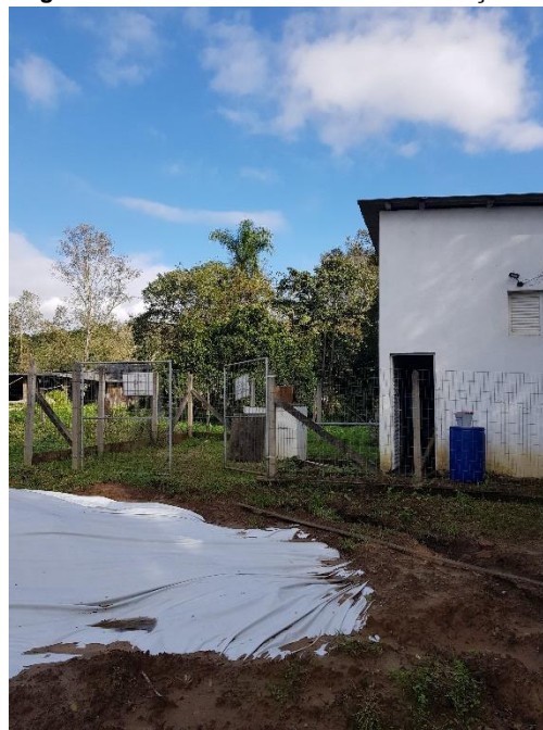
Figura 2b – Vista frontal do terreno do Poço P-1
