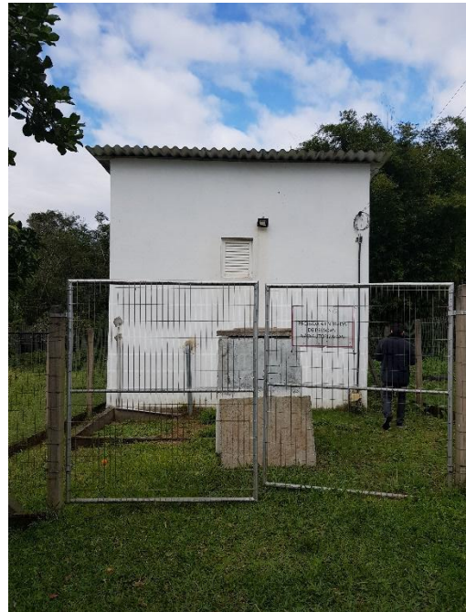
Figura 1b – Vista frontal do terreno do Poço P-4.
