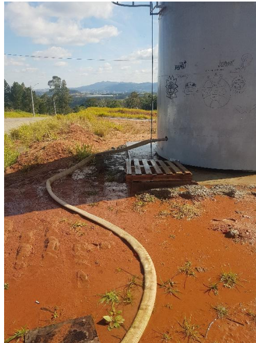
Figura 10b – Sistema de Abastecimento do Caminhão-pipa.
