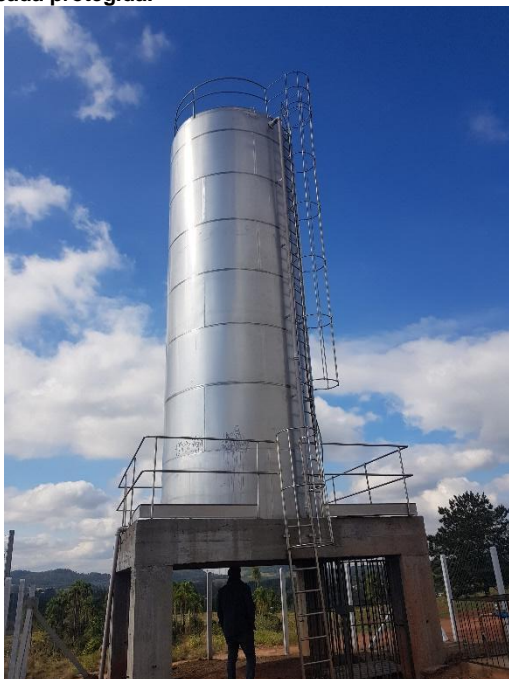
Figura 8e – Reservatório Loteamento Azaleias, guarda-corpo e escada protegida.
