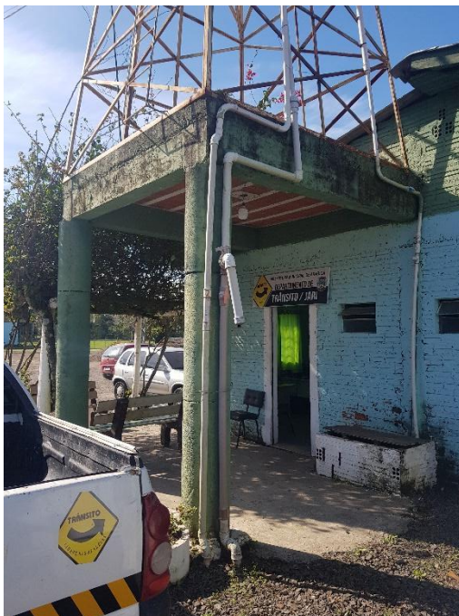
Figura 6g – Tubulações e conexões do reservatório R-5.
