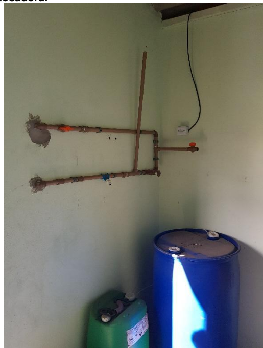
Figura 3f – Casa de apoio (parte interna), barrilete de produtos químicos em PVC, com ausência de bomba dosadora.
