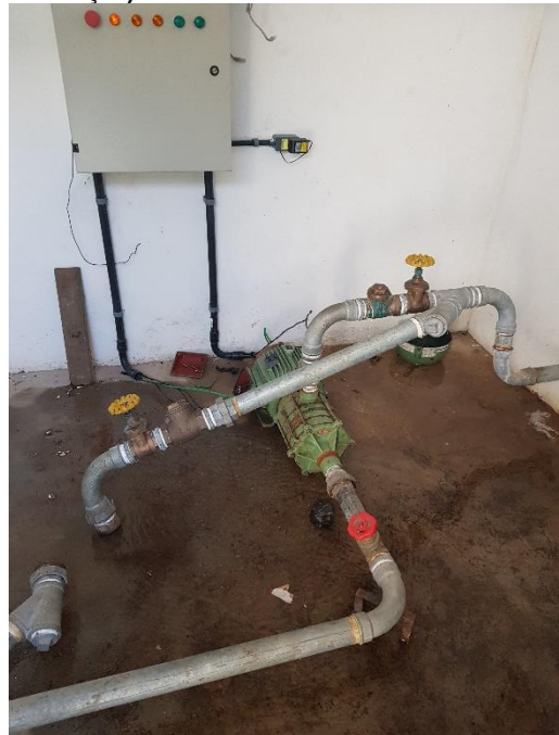
Figura 12h – Conjuntos Motobomba e Barriletes em FºFº (1 dos Conjuntos Motobomba estava em manutenção).
