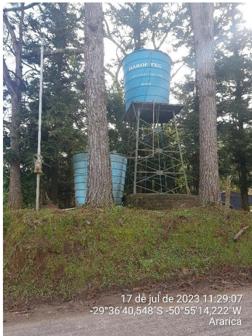
Figura 9c – Reservatório Apoiado de Fibra.
