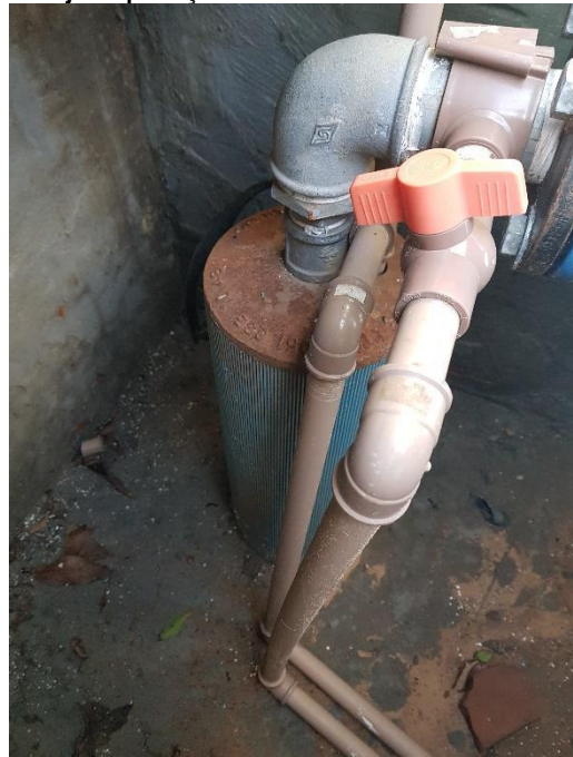
Figura 3f – Casa de apoio (parte interna), barrilete de produtos químicos em PVC, com ausência de bomba dosadora.
