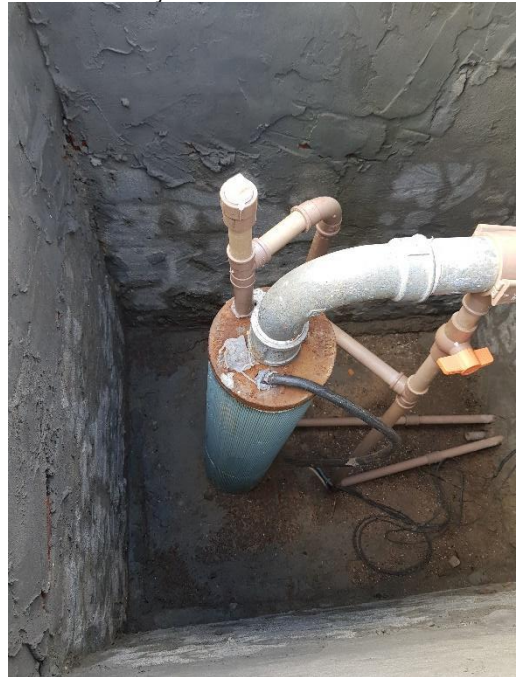
Figura 1f – Caixa de proteção do Poço P-4, com laje de proteção, ponta do tubo com revestimento do poço em PVC (azul), barrilete em FºFº com macromedidor e válvula de retenção.
