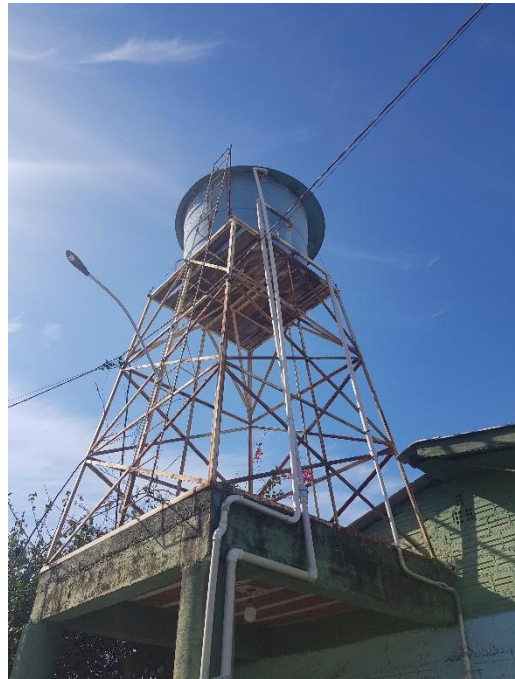
Figura 6f – Vista do reservatório elevado – R-5 Secretaria de Obras.
