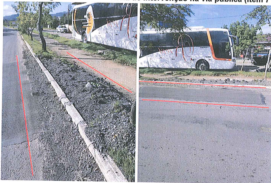
Figura 7 - Registro fotográfico da ocorrência de intervenção na via pública (item 7 da tabela 1)
