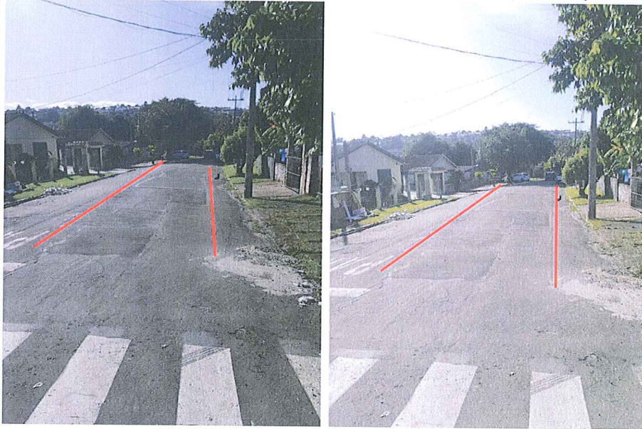
Figura 2 - Registro fotográfico da ocorrência de intervenção na via pública (item 1 da tabela 1)
