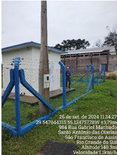
Poço SFR 03A
