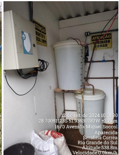
Interior da casa de química.
