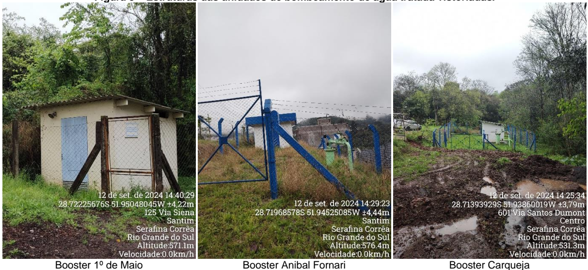
Figura 8 – Estruturas das unidades de bombeamento de água tratada vistoriadas.
