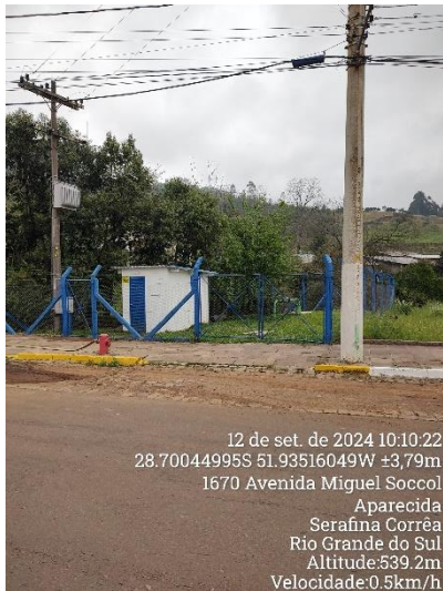
Face frontal do imóvel onde se localiza o poço e casa de química para tratamento simplificado
