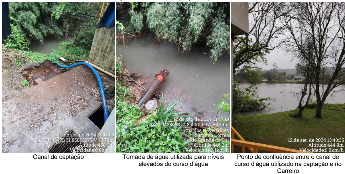
Figura 3 – Ponto de captação superficial.
