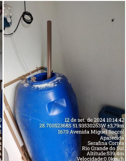
Tambor contendo solução de fluossilicato de sódio a ser dosada no sistema.
