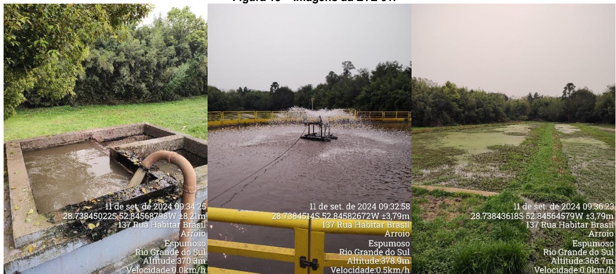
Figura 13 – Imagens da ETE 01.
