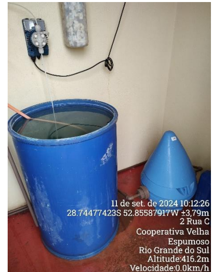
Figura 6 – Tratamento simplificado realizado no sistema de abastecimento por técnicas consorciadas.
