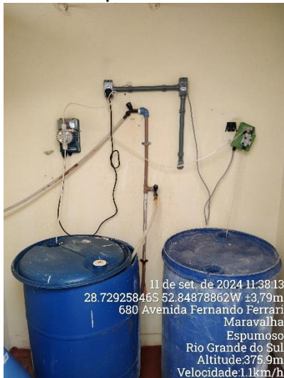
Figura 4 – Tratamento simplificado realizado no sistema de abastecimento por dosagem de produtos.
