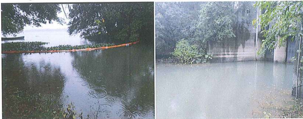
Figura 12– Registro fotográfico da captação superficial de Charqueadas.
