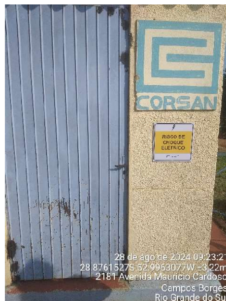
Figura 6 - Exterior da Casa de Química simplificada do poço 07.
