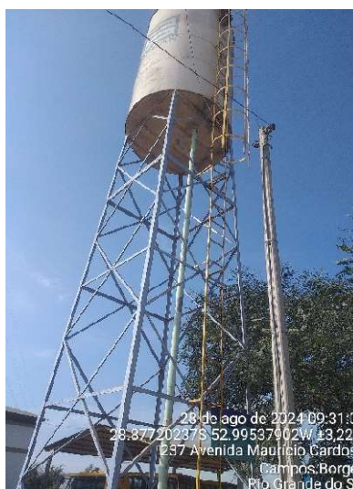
Figura 8 - Reservatório R2 Capacidade: 10 m 3 - Metálico
