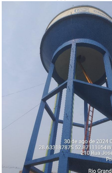
Figura 16 - Reservatório R4 Capacidade: 100 m 3 - Concreto Armado
