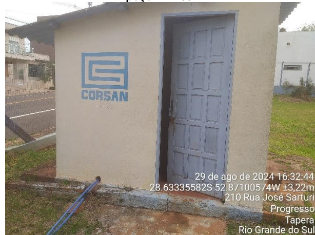
Figura 11 - Exterior da Casa de Química simplificada do poço TAP 03.
