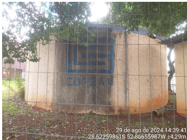
Figura 15 - Reservatório R2 Capacidade: 100 m 3 - Concreto Armado
