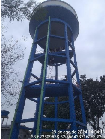
Figura 14 - Reservatório R1 Capacidade: 150 m 3 - Concreto Armado
