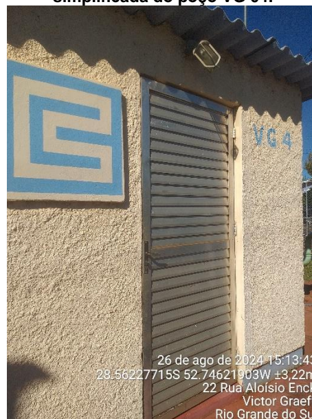
Figura 6 - Exterior da Casa de Química simplificada do poço VG 04.
