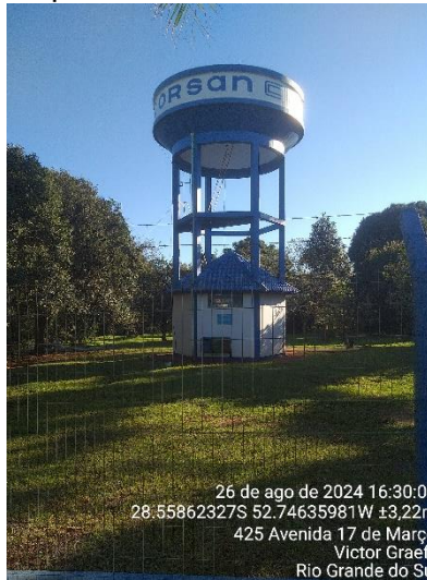
Figura 7 - Reservatório R1 Capacidade: 50 m³ - Concreto Armado
