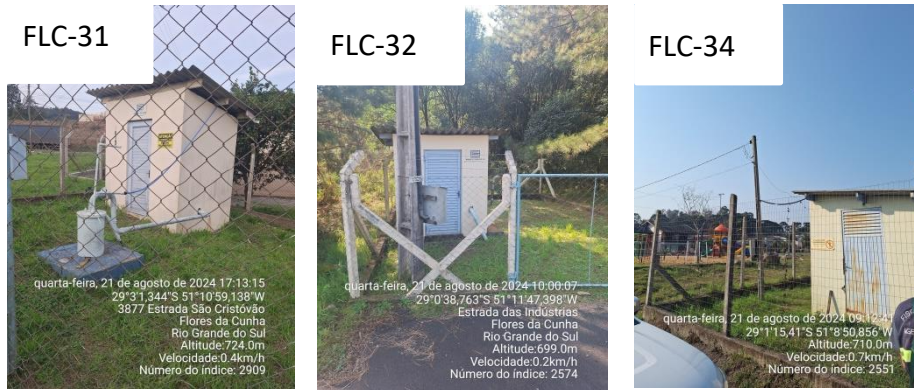
Figura 06: Identificação dos poços componentes do SAA de Flores da Cunha.
