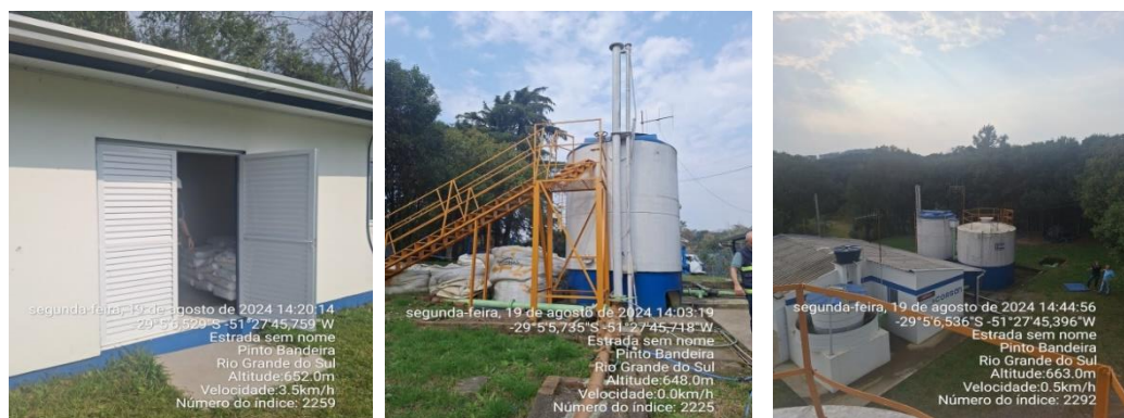
Figura 03: Estruturas da ETA de Pinto Bandeira.
