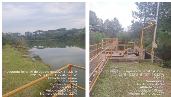
Figura 1: Barragem de captação superficial em Pinto Bandeira/RS:
