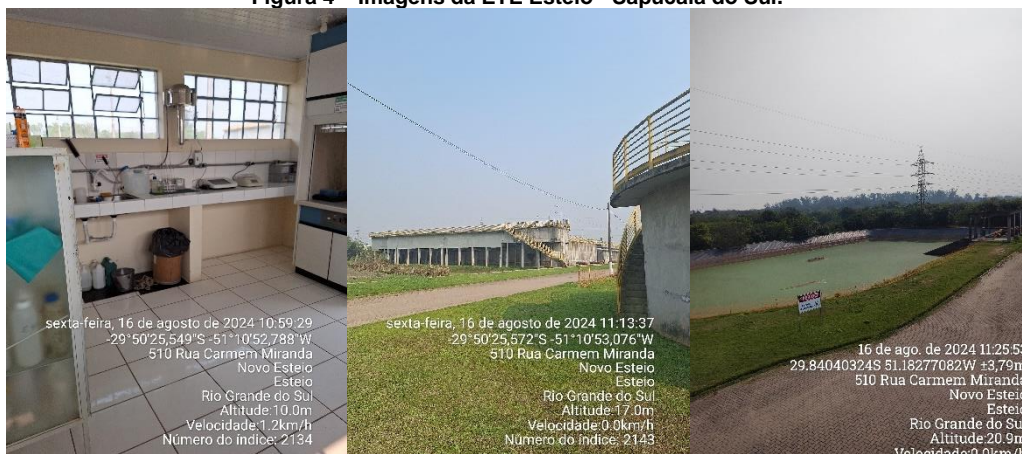
Figura 4 – Imagens da ETE Esteio - Sapucaia do Sul.
