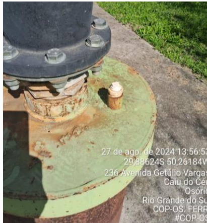
Poço OSO-08- Osório
