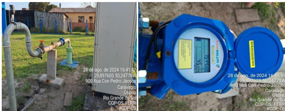
Poço- Reservatório R04-Osório
