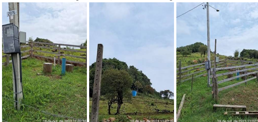
Figura 7: Poço 6 – Morro da Figueira
