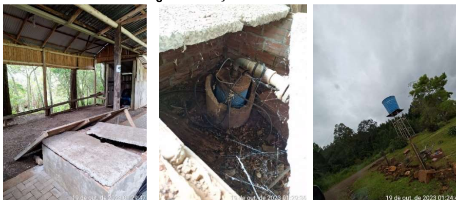
Figura 18: Poço 17 – Alto Rolante.
