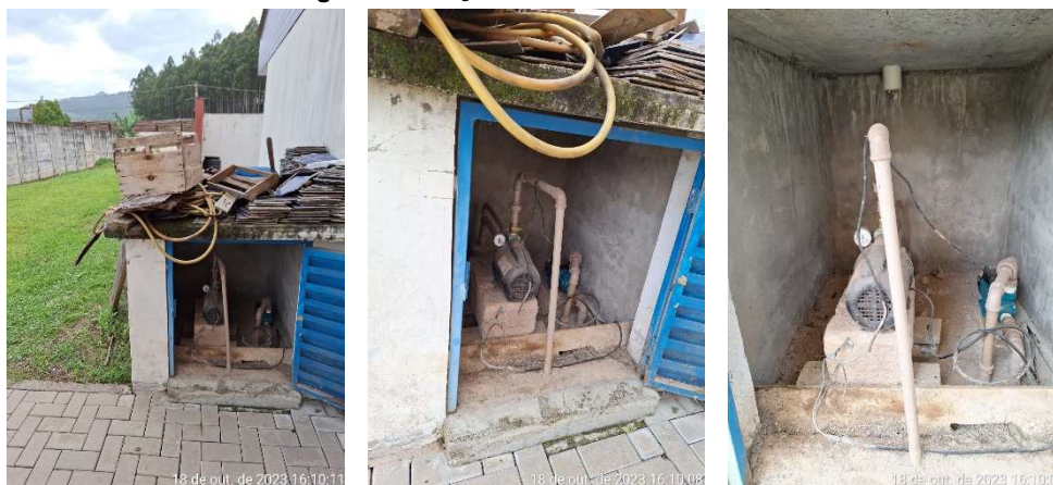
Figura 19: Poço 18 – EMEI Alto Rolante
