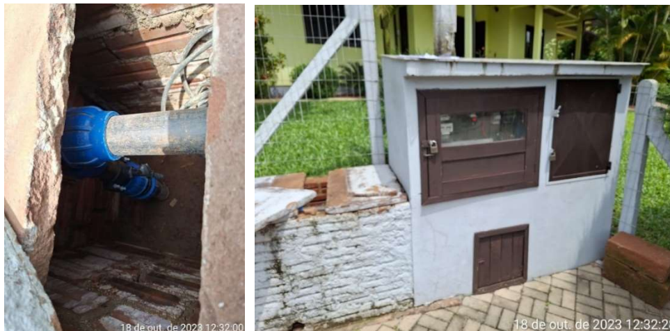
Figura 17: Poço 16 – Alto Rolante.
