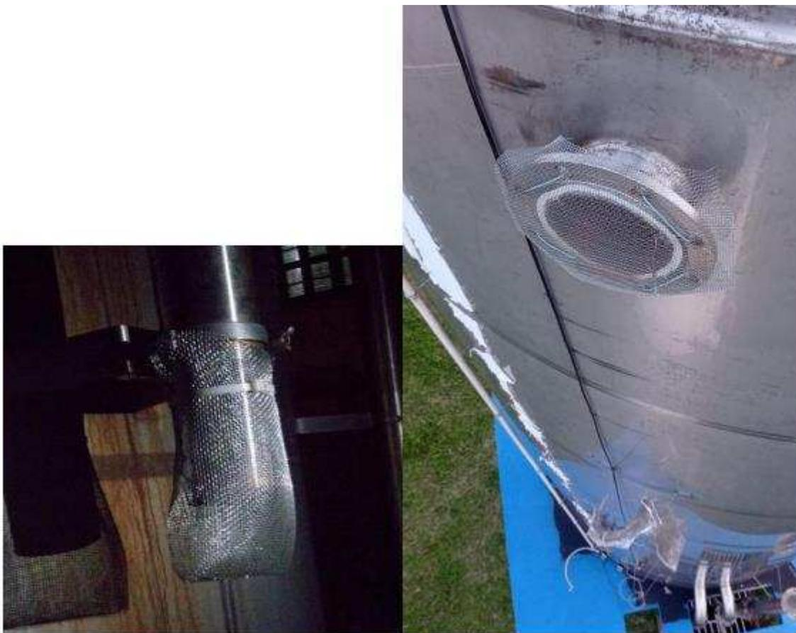
Figura 05 Tubulação de ventilação do R6 (Conceição) protegida com tela aço inox.
