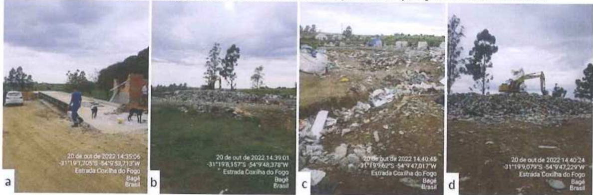
Figura 6: Registro fotográfico da unidade de transbordo: a) Vista da obra de instalação da balança rodoviária; b) Vista do local de transbordo; c) Vista da presença de catadores (ao fundo); Vista da operação da retroescavadeira.
